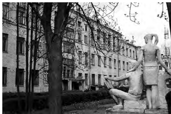
Здание Политехникума ЛВЦ в Павловске
