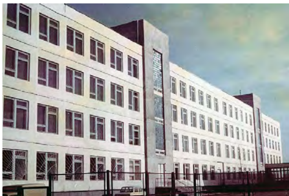
Новый корпус Иркутского УПП. 1984 г.
